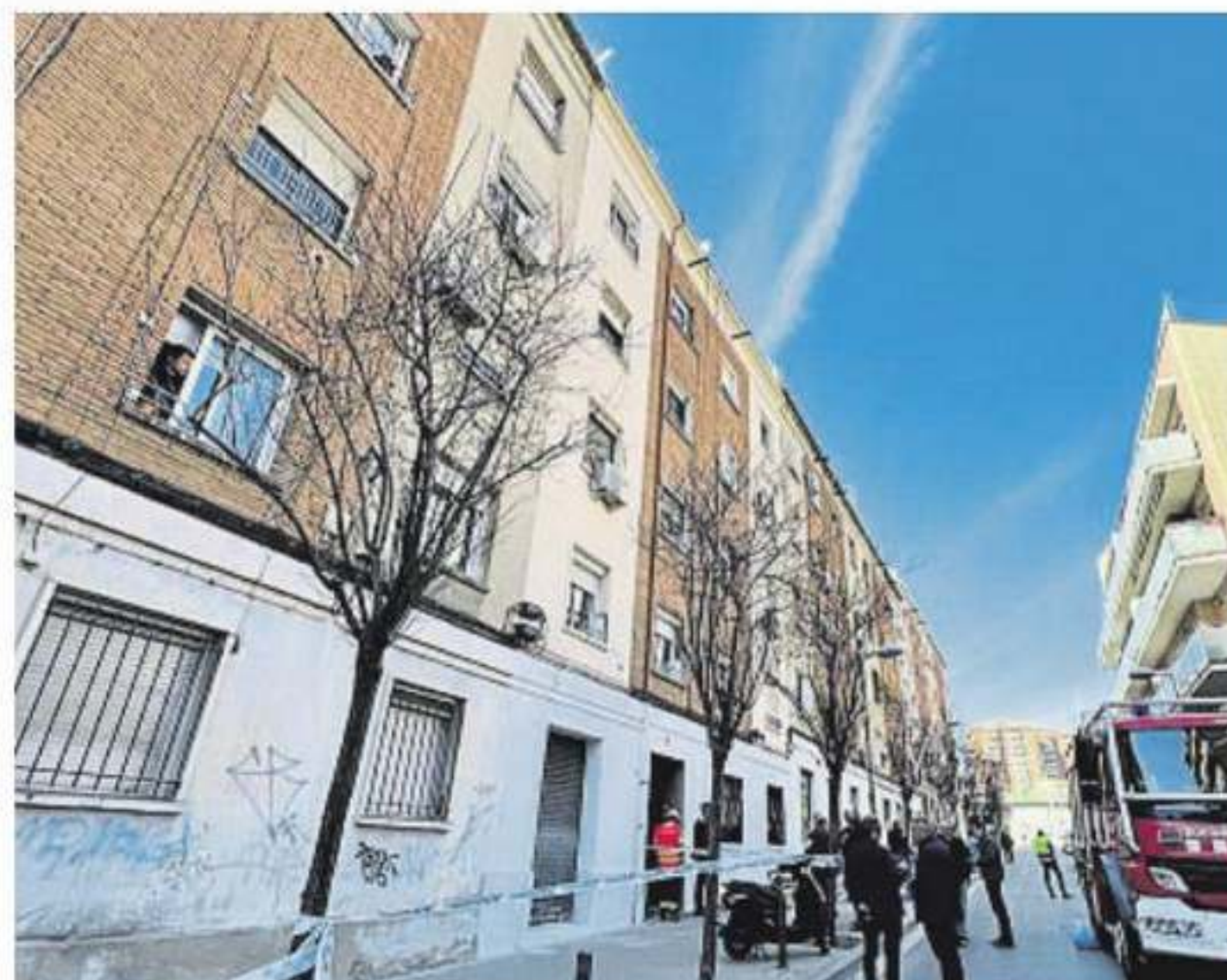
Los edificios de la calle Canigó serán inspeccionados a fondo
